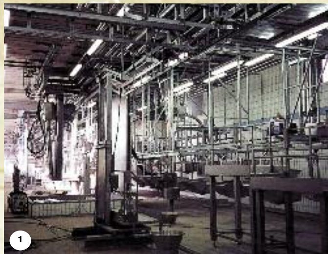
1 Impianto lavorazione carni in fase di allestimento.
